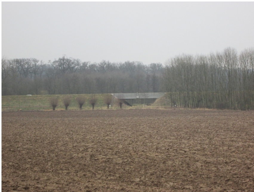
De wildtunnel die op de verkeerde plek is gesitueerd
