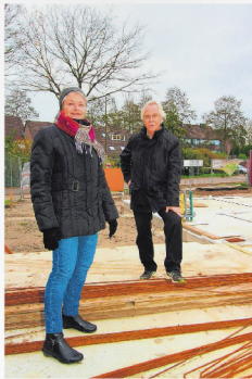
Het 'Eco Huus' van Frans en Mariette van Herwijnen aan de Loostraat in Huissen is in aanbouw.
