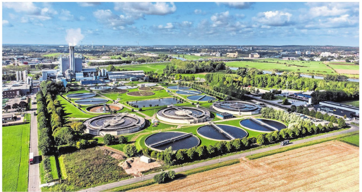
▲ De waterzuiveringsinstallatie in Duiven. FOTO JAN RULAND VAN DEN BRINK
